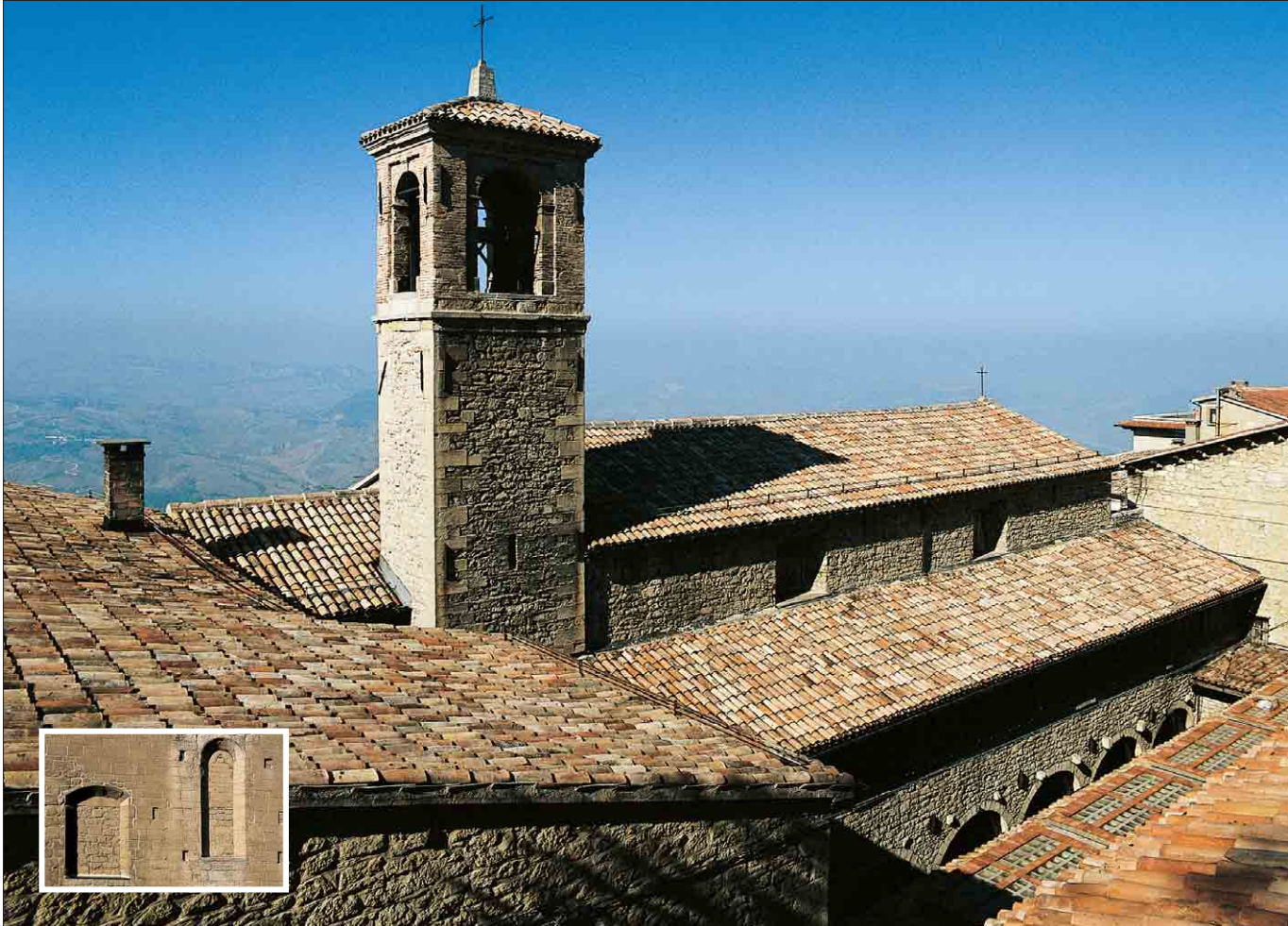
Il campanile quadrangolare della Chiesa di San Francesco. Nel dettaglio, particolare delle monofore murate in seguito ai lavori di rifacimento.
