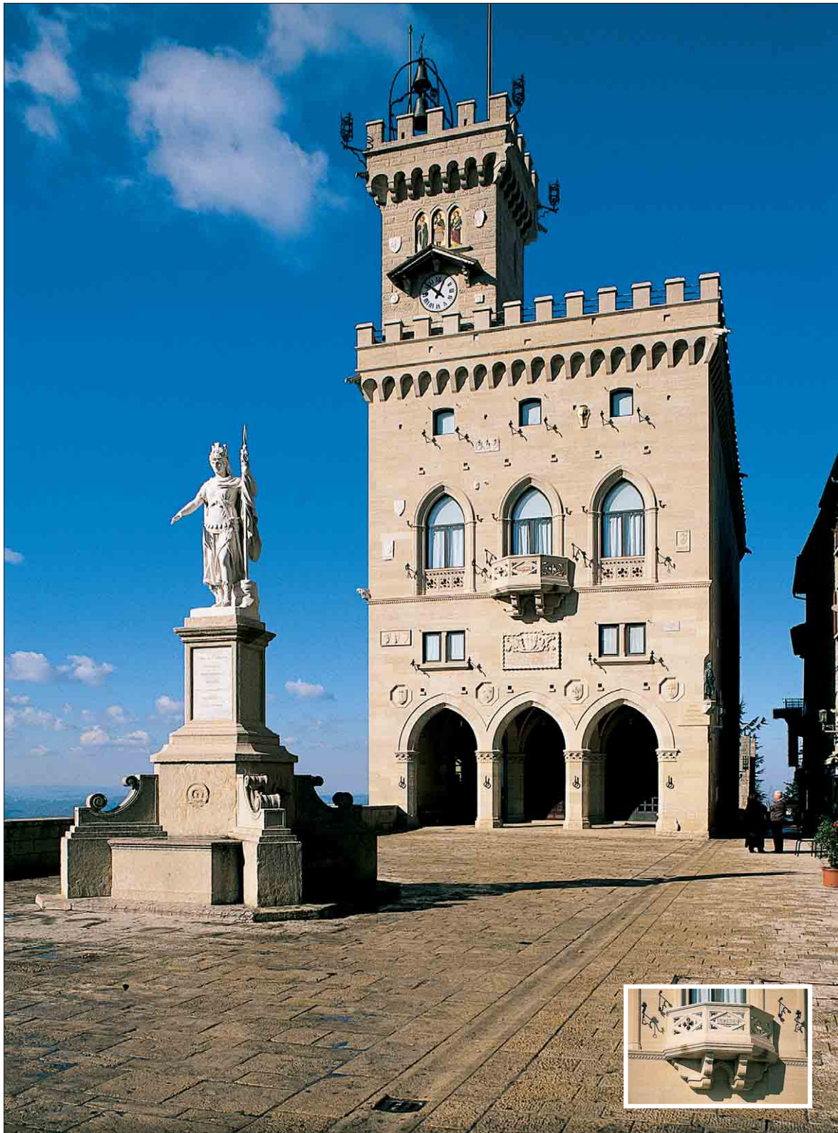
Il Palazzo Pubblico sullo sfondo della piazza della Libertà. Nel dettaglio, il balconcino poligonale in pietra traforata.
