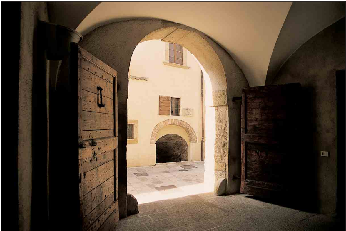
L'Antico Monastero Santa Chiara: in alto, la complessa struttura dell'edificio; in basso, il grande arco dell'ingresso. Nel dettaglio, il tetto del piccolo campanile della chiesa sormontato da una croce in ferro battuto.
