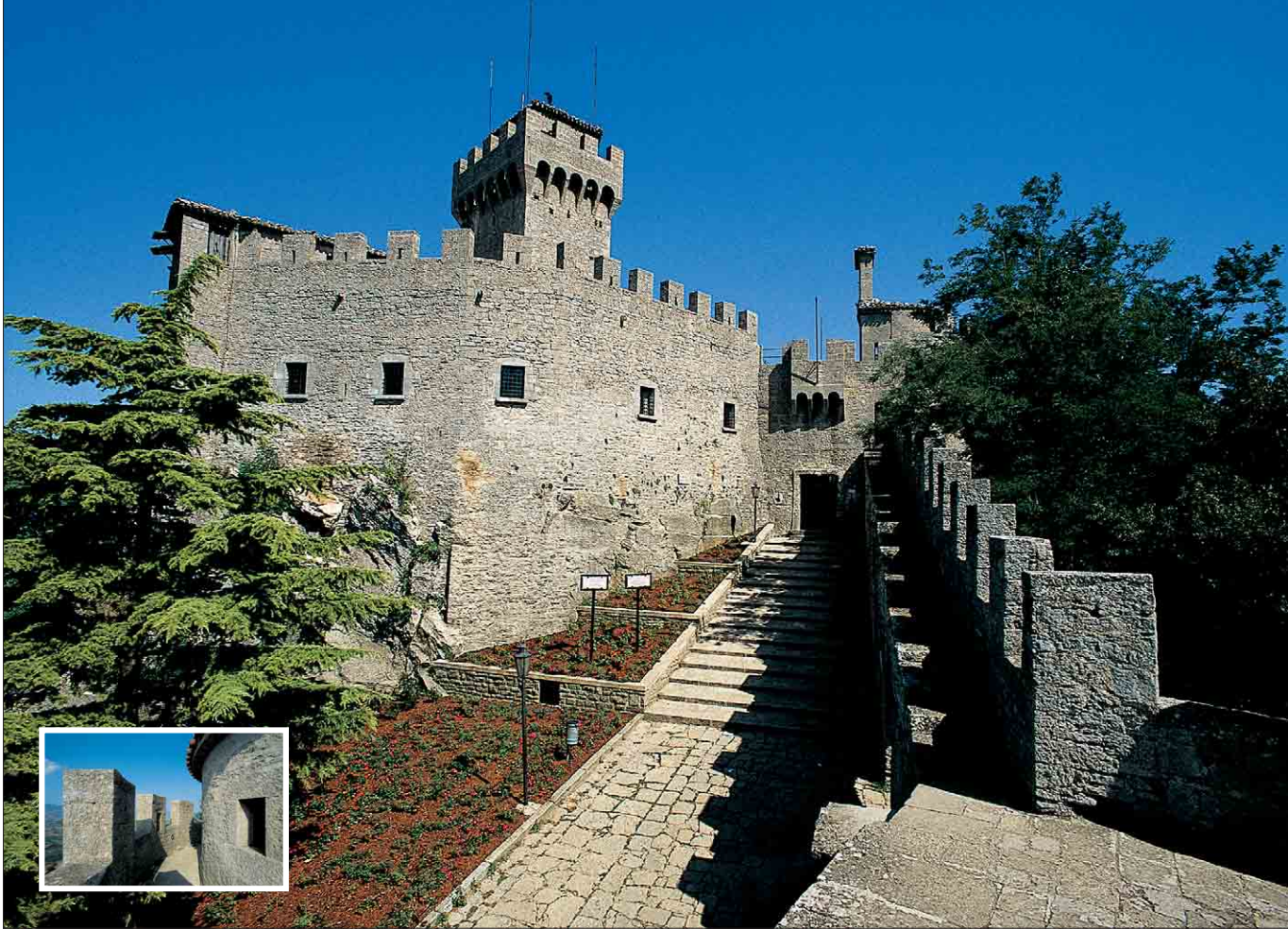
La seconda torre circondata da un alto muro esterno. Nel dettaglio, particolare del baluardo.
