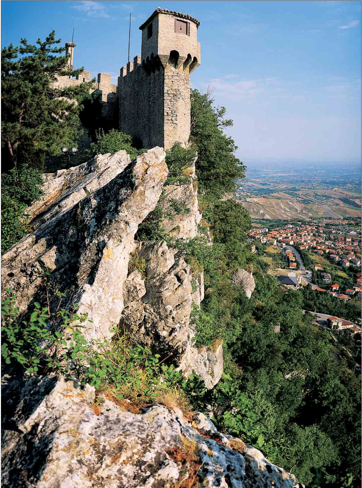
Il torrioncino pentagonale costruito sullo sperone roccioso della rupe.
